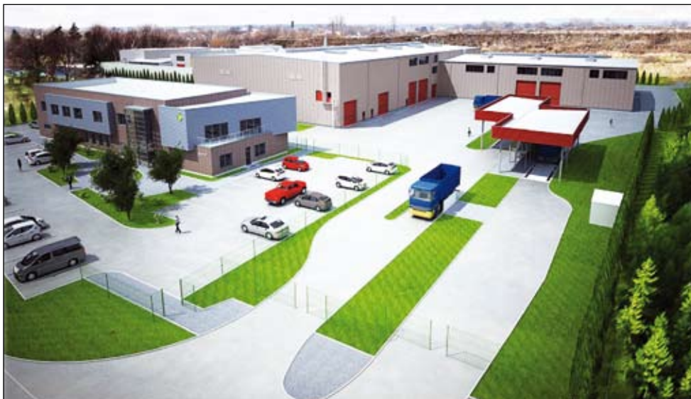
Tak będzie wyglądał budowany obecnie zakład segregacji w Tychach, który pozwoli spełnić unijne normy w zakresie składowania odpadów.
