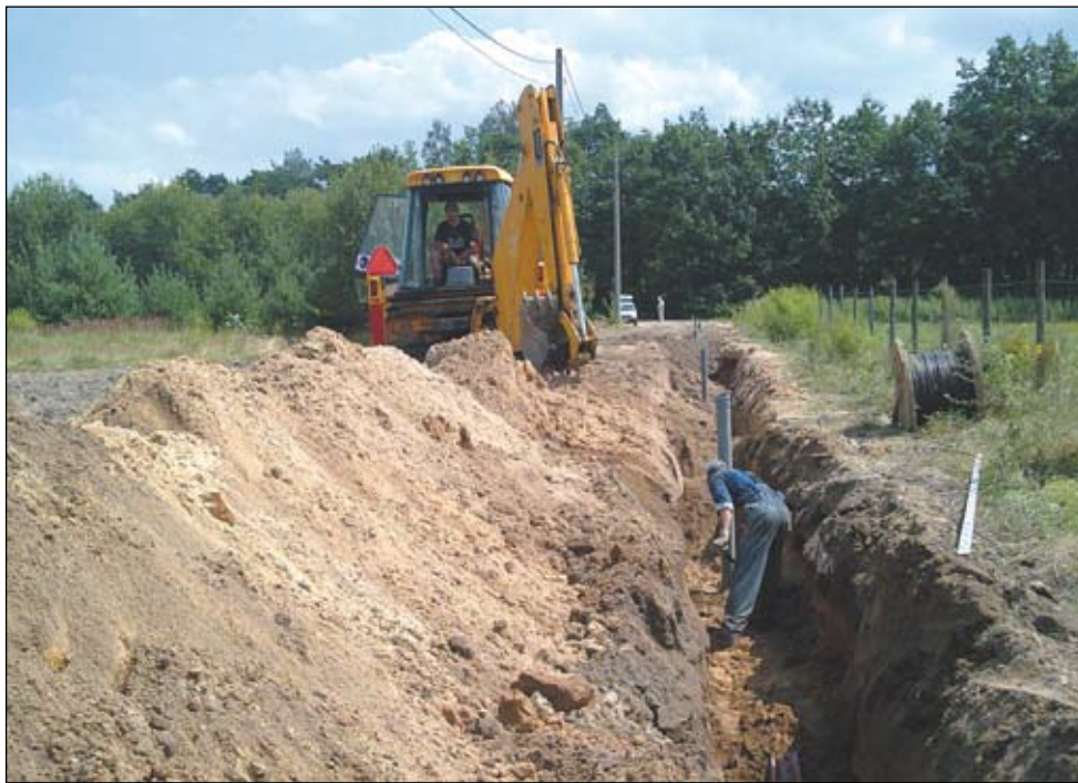
Budowa kanalizacji w ostatnich latach zapewniła Imielinowi wysokie miejsce w rankingu.
