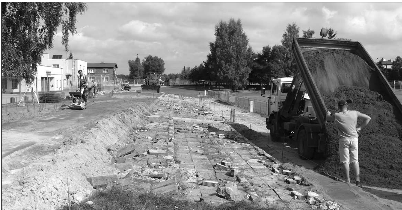
Budowa nowych trybun na 540 miejsc na stadionie Pogoni przy ul. Hallera.
